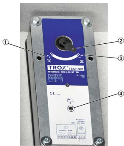
Slika 39: Otvoravanje/zatvaranje pokretača (klapna za kontrolu dima je otvorena)
