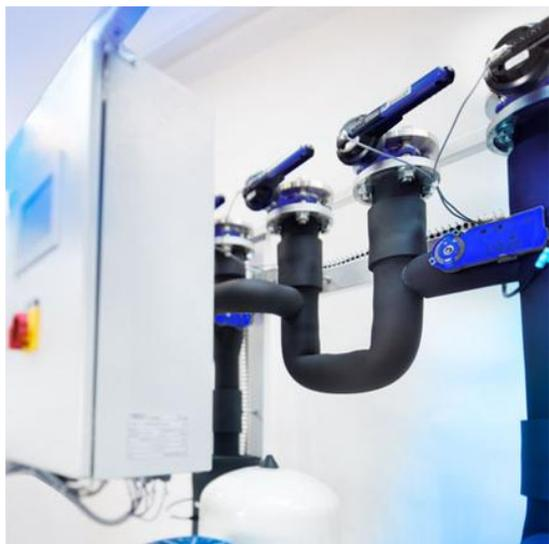
Eko dizajn direktiva Evropske unije propisuje da počev od 2018. godine klima komore moraju da imaju efikasnost rekuperacije toplote od preko 73%, a ukoliko su u pitanju sistemi sa glikolnim izmenjivačem, preko 68%. TROX-ov sistem sa glikolnim izmenjivačem i TROX-ovom hidrauličkom jedinicom koja sadrži specijalnu regulaciju za ovaj sistem, garantuje efikasnost
